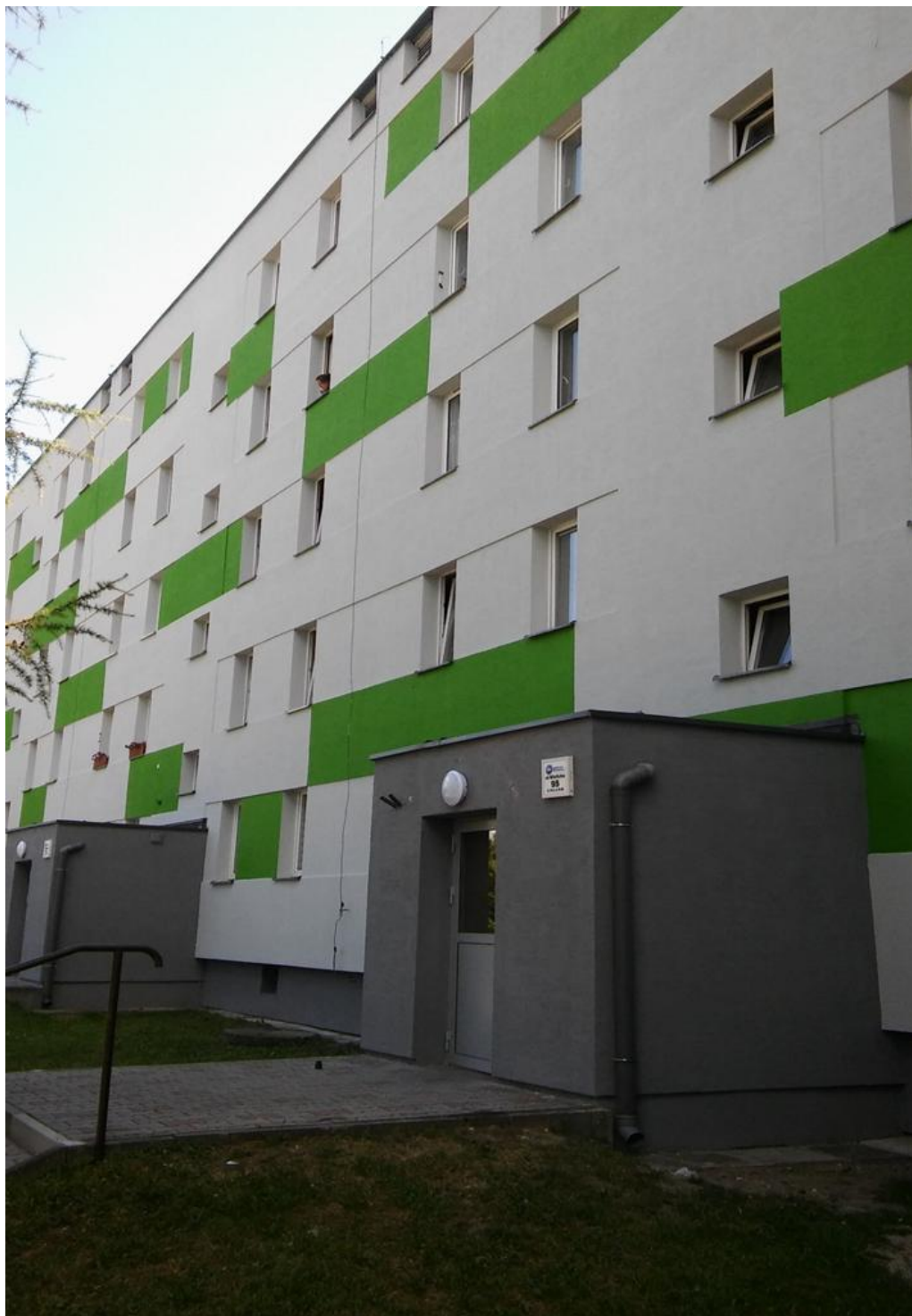
Fot.2. Ten sam budynek po zastosowaniu systemowego rozwiązania opartego na Fast Protektor i malowanie farbą silikonową Fast Sil.
